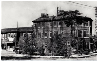
1945年後期の撮影と思われる旧日本陸軍当時の司令部建物。木造で、飛行場に面した東側部分が一部三階建てになっており、窓が多い特殊な構造になっていた。2001年3月解体。
